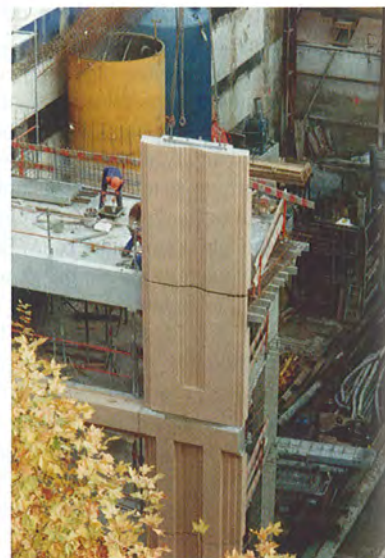
La façade a été démontée puis reconstruite
